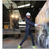
La destruction de l'ancien Garage Dillmann a démarré. Photo RL/Armand FLOHR
